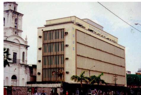
Edifício INSS, antigo INPS
