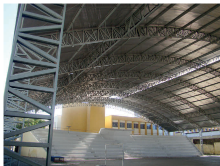
Coberta em estrutura metálica da quadra desportiva do CEU
