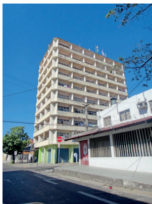
Apartamento residencial de oito andares e comércio no térreo, localizado na Pedro Pereira esquina com Princesa Isabel
