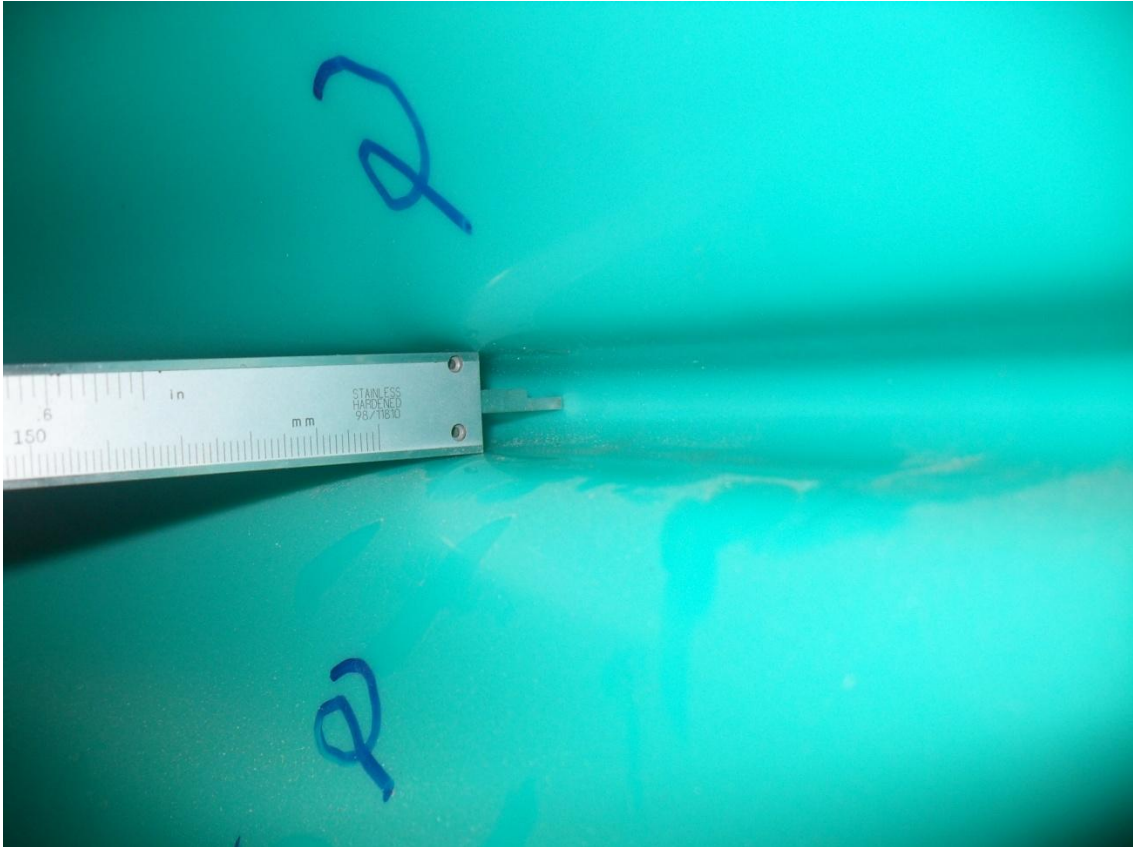
Figura 52 - Região interna 2 do anel de sustentação do PV 2.
