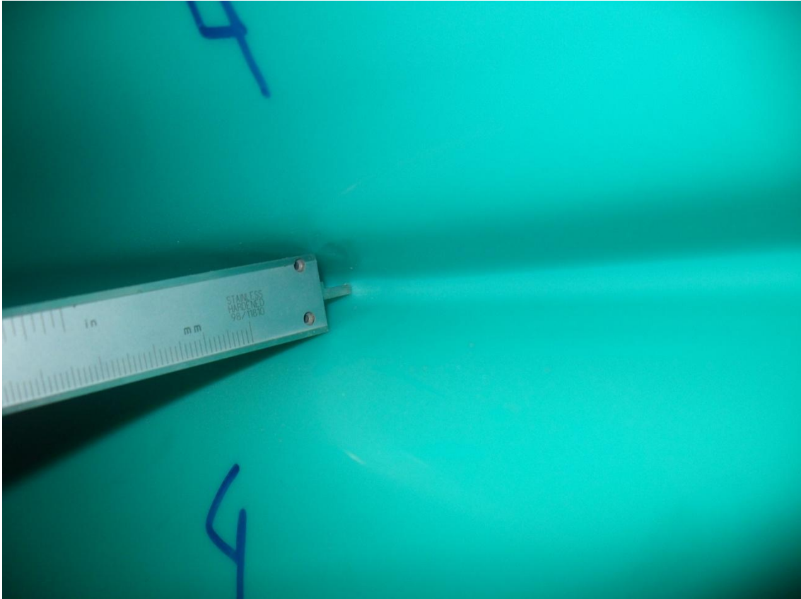
Figura 54 - Região interna 4 do anel de sustentação do PV 2.
