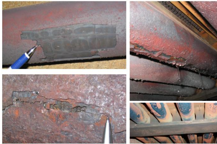
Figura 9 - Deteriorização em serpentinhas causada por oxidação em altas temperaturas [6].
