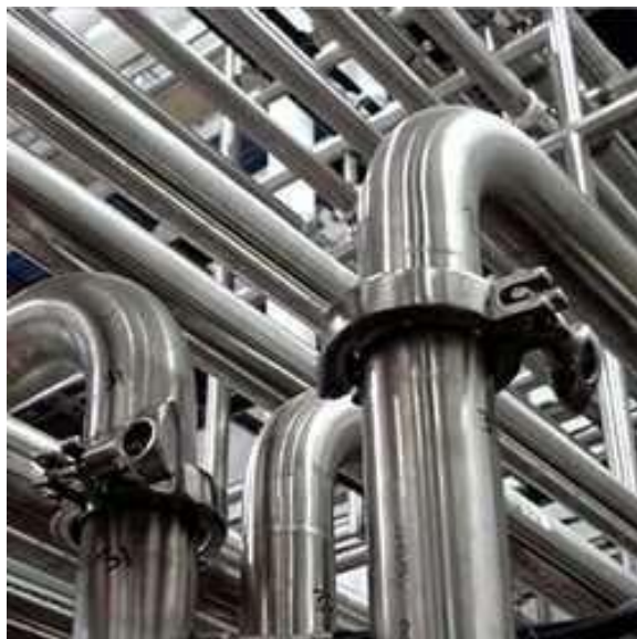
Figura 1. Aplicação do aço ZERON 100 na indústria química.
