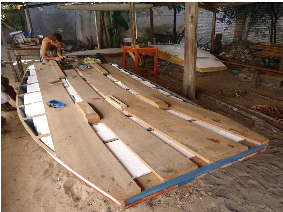
Figura 5 – Pacote de isopor em construção, com o detalhe do forramento com isopor sob o convés. (Fonte: foto do autor)
