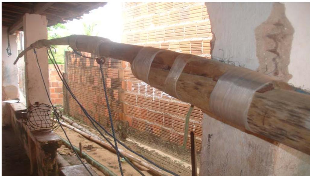
Figura 47 - Mastro apresentando junções do toco, emendas e ponteira da emenda. (Fonte: Foto do autor)
