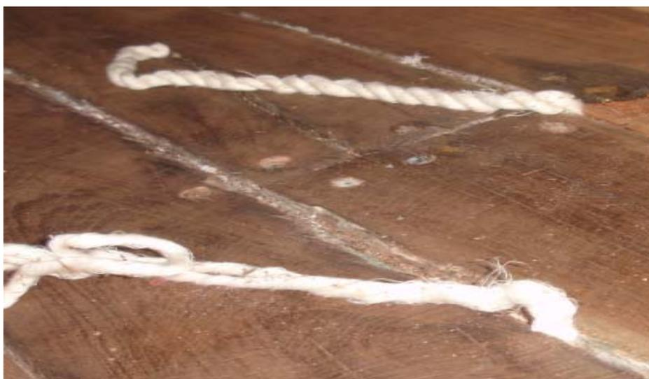
Figura 52 - Detalhe do fio de algodão trançado em preenchimento dos espaçamentos entre tábuas. (Fonte: Foto do autor)
