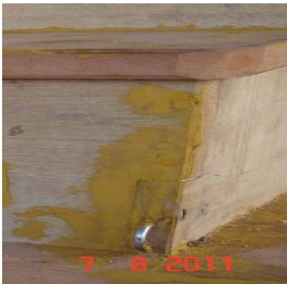
Figura 41 – Emenda utilizada na junção lateral das escotilhas.
