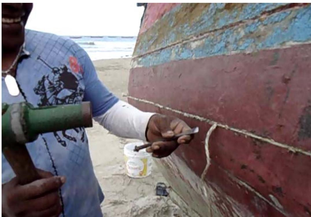
Figura 50 – Preenchimento do espaçamento entre tábuas com cordão de fios de algodão trançado. (Fonte: Foto do autor)
